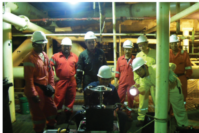
Kerja pemasangan bebibir untuk penyediaan ujian hidrostatik di Pelantar Minyak dan Gas Bekok C, milik Petronas Carigali Sdn Bhd di luar perairan Terengganu. Blind flange work for hydrostatic test preparation in Bekok C oil and gas platform owned by Petronas Carigali Sdn Bhd, off the coast of Terengganu.
