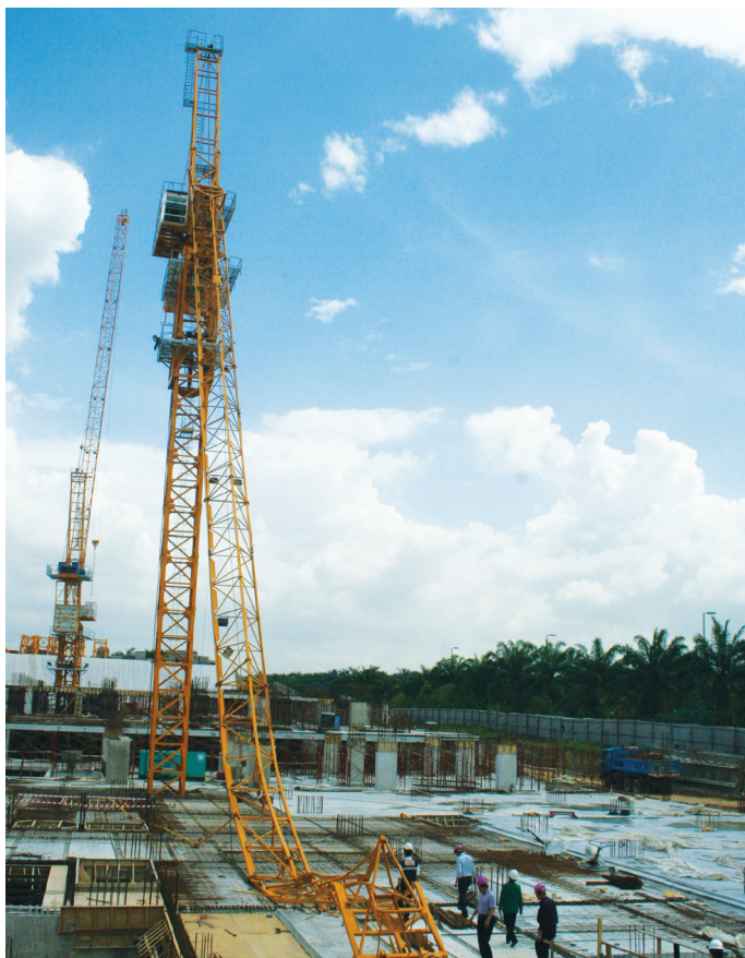
Gambar 9: Pegawai BKF membuat penyiasatan di tapak kemalangan kren menara di Selangor.
