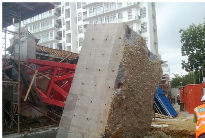
Gambar 2: Kegagalan tapak asas sebuah kren menara di Kuala Lumpur.
