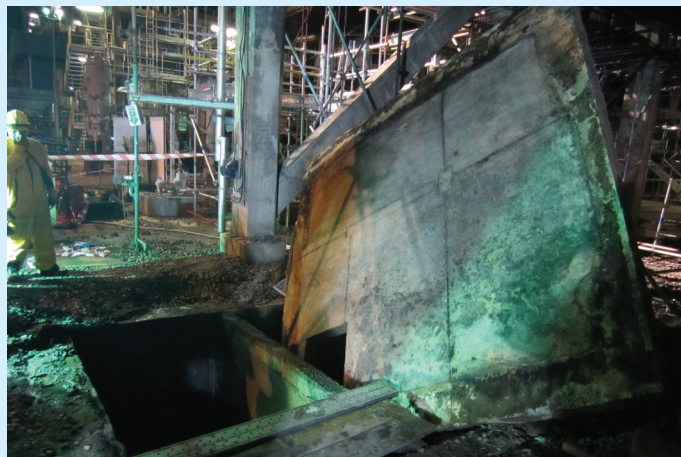
Gambar 8: Penutup longkang air ribut yang telah terbuka semasa letupan dan kebakaran di sebuah loji penapisan minyak. Photo 8: A storm water drain cover blown off by an explosion and fire in an oil refinery.
