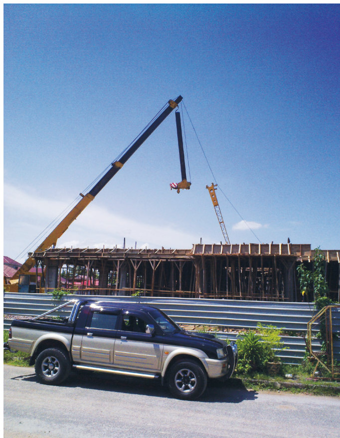
Gambar 10: Kren bergerak yang mengalami kegagalan di bahagian struktur joran, di sebuah tapak pembinaan di Kedah.
