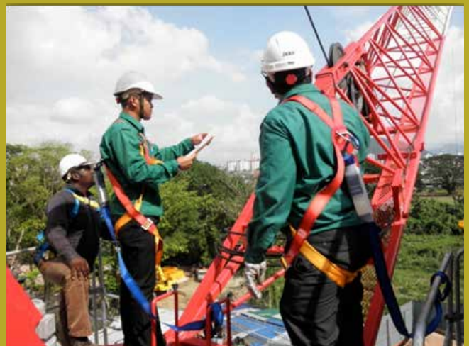
Pemeriksaan ke atas kren menara bagi tujuan pendaftaran jentera Inspection on tower crane for purposes of machinery registration
