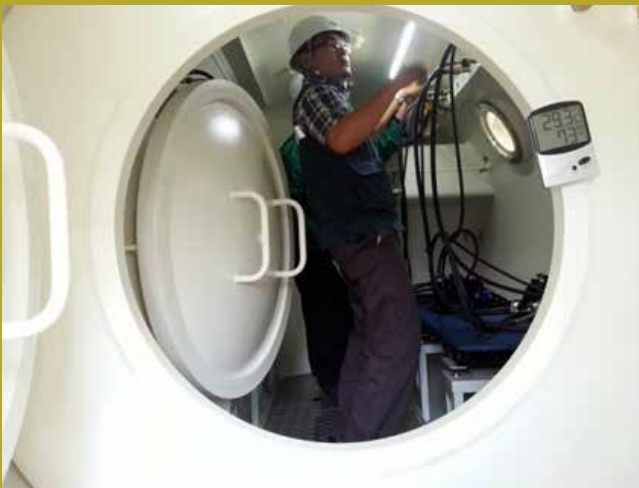
Pegawai melakukan pemeriksaan pertama ke atas pengandung tekanan tak berapi Officer conducting first inspections on unfired pressure vessels
